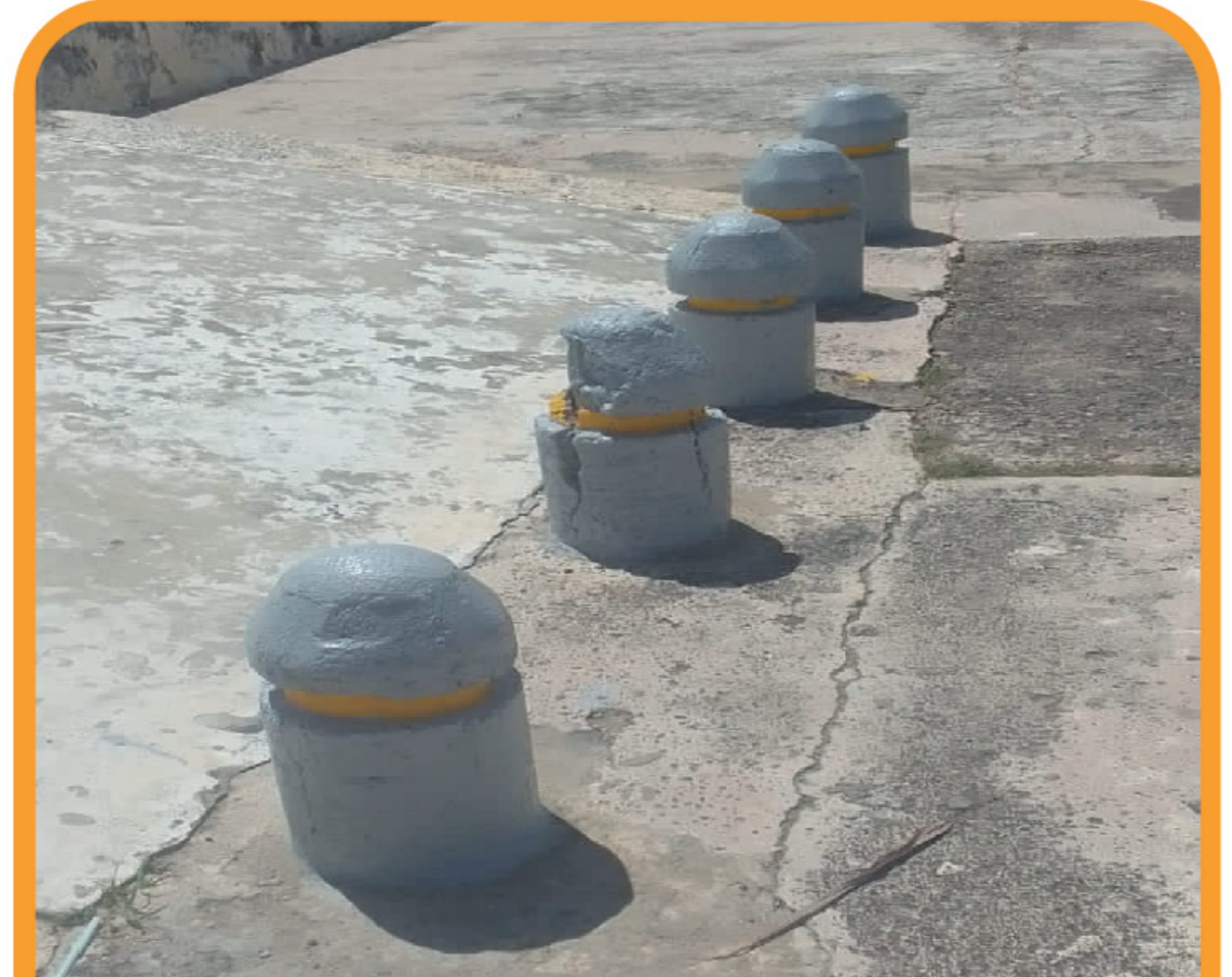
Mantenimiento de bolardos Plaza de Armas
