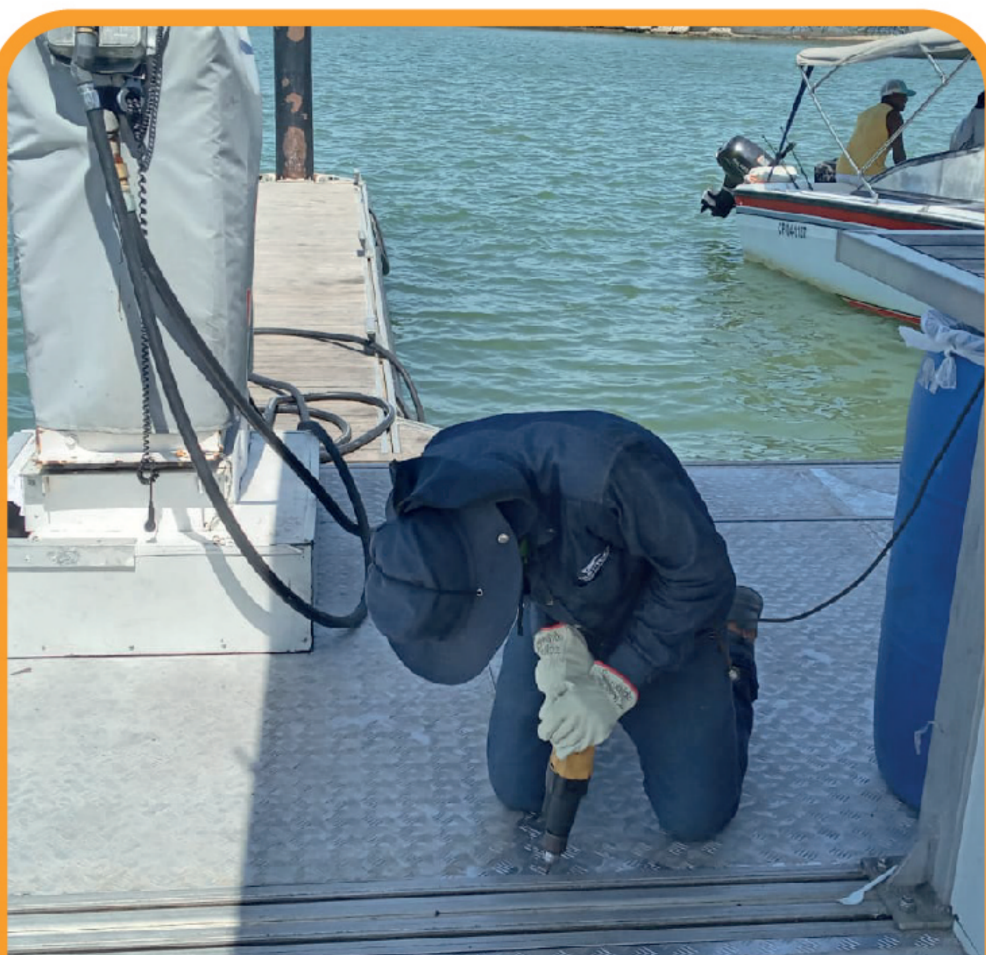
Instalación piso en aluminio en la EDS
