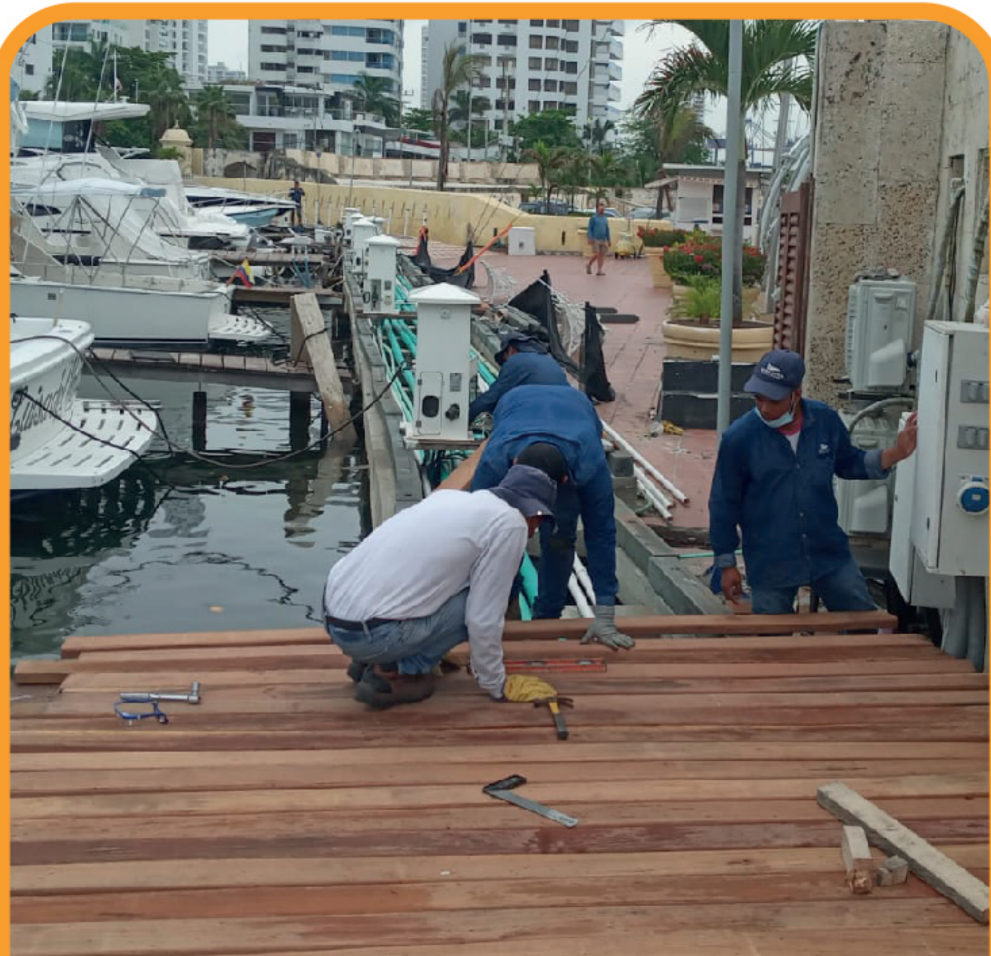
Construcción muelle contiguo a baños Muelle 1
