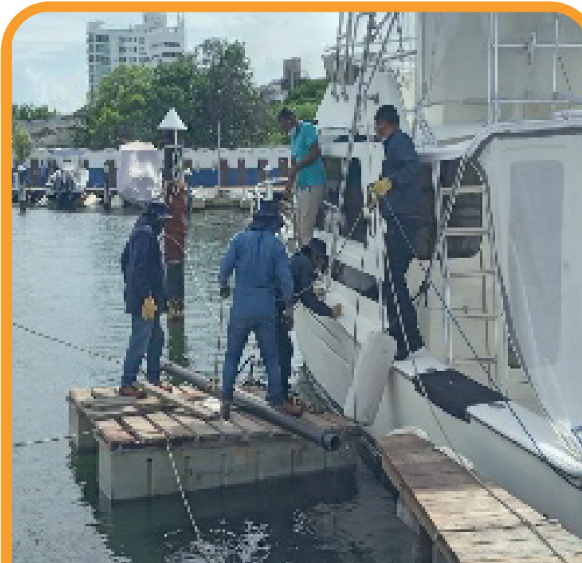
Construcción muelle contiguo a baños Muelle 1
