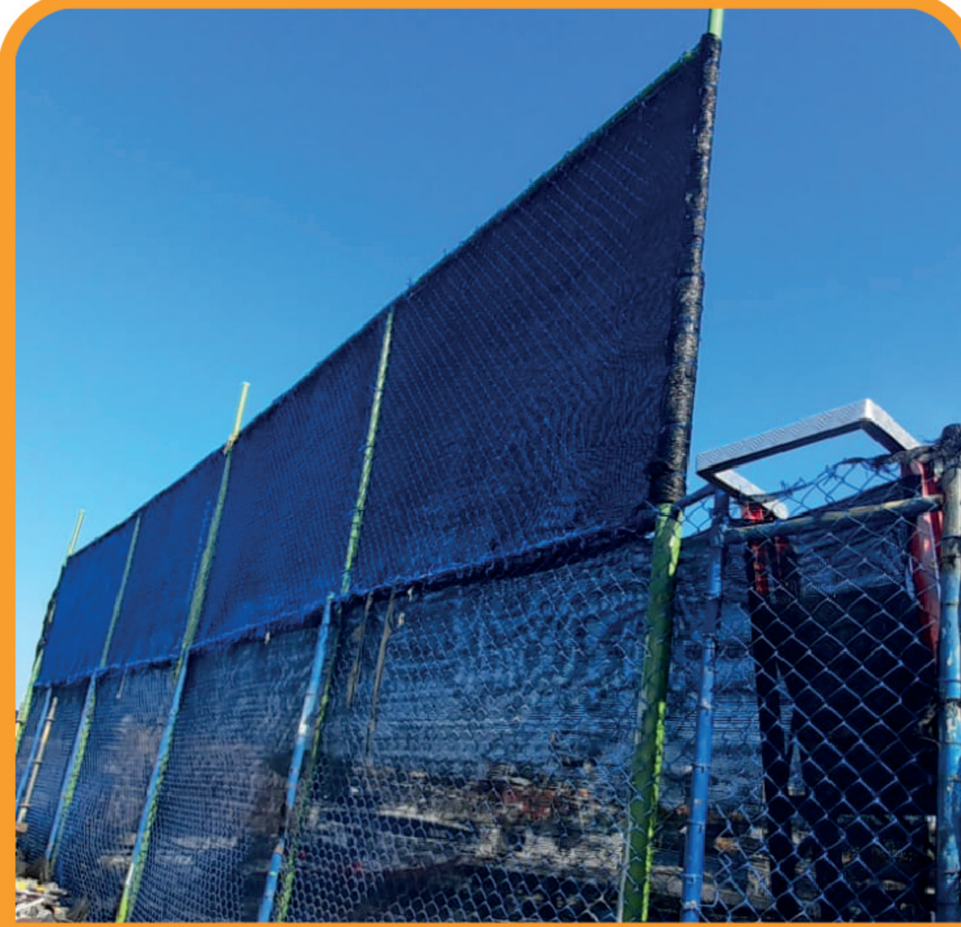
Mantenimiento de malla en sincro elevador
