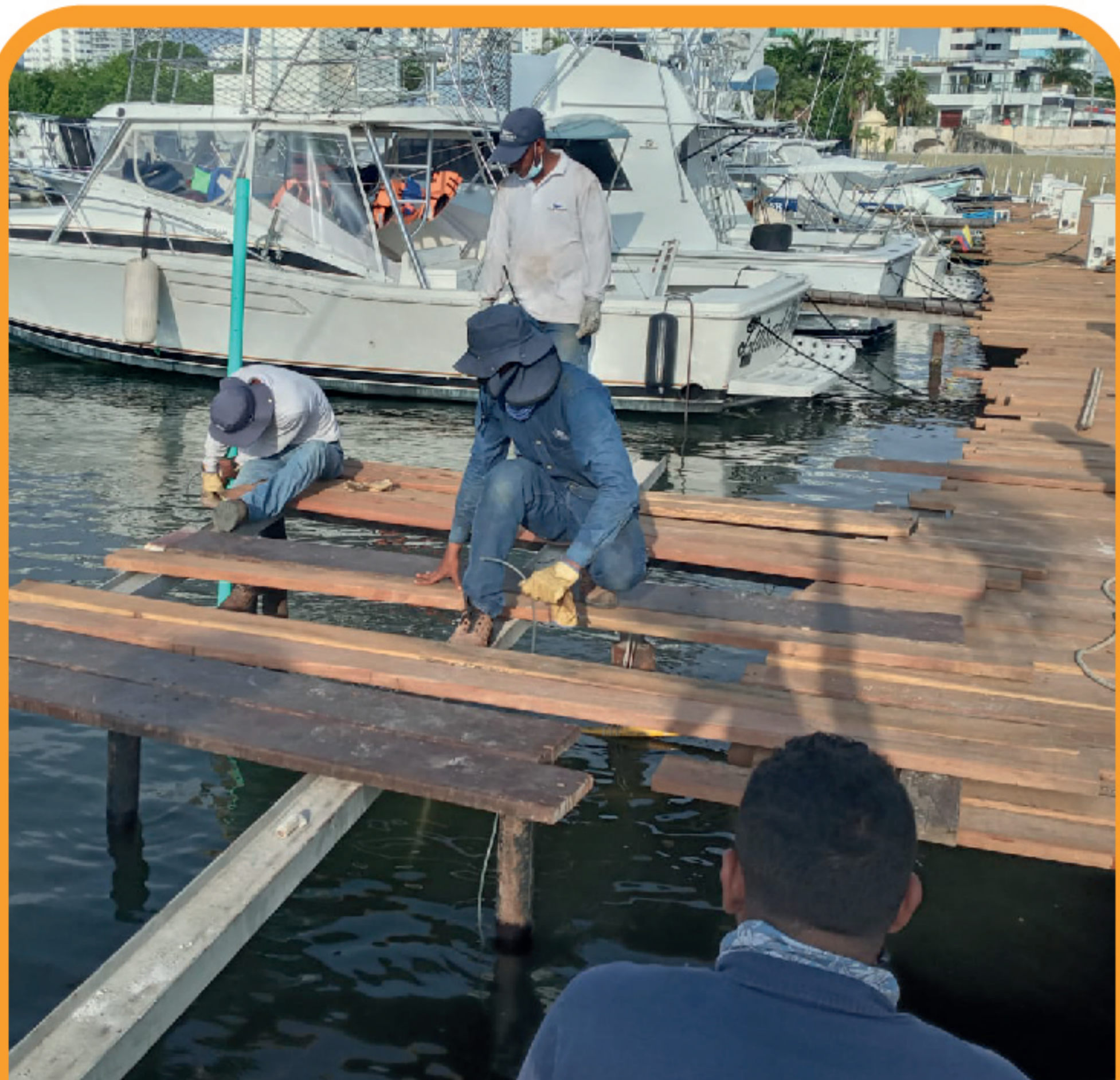
Construcción muelle contiguo Muelle 1
