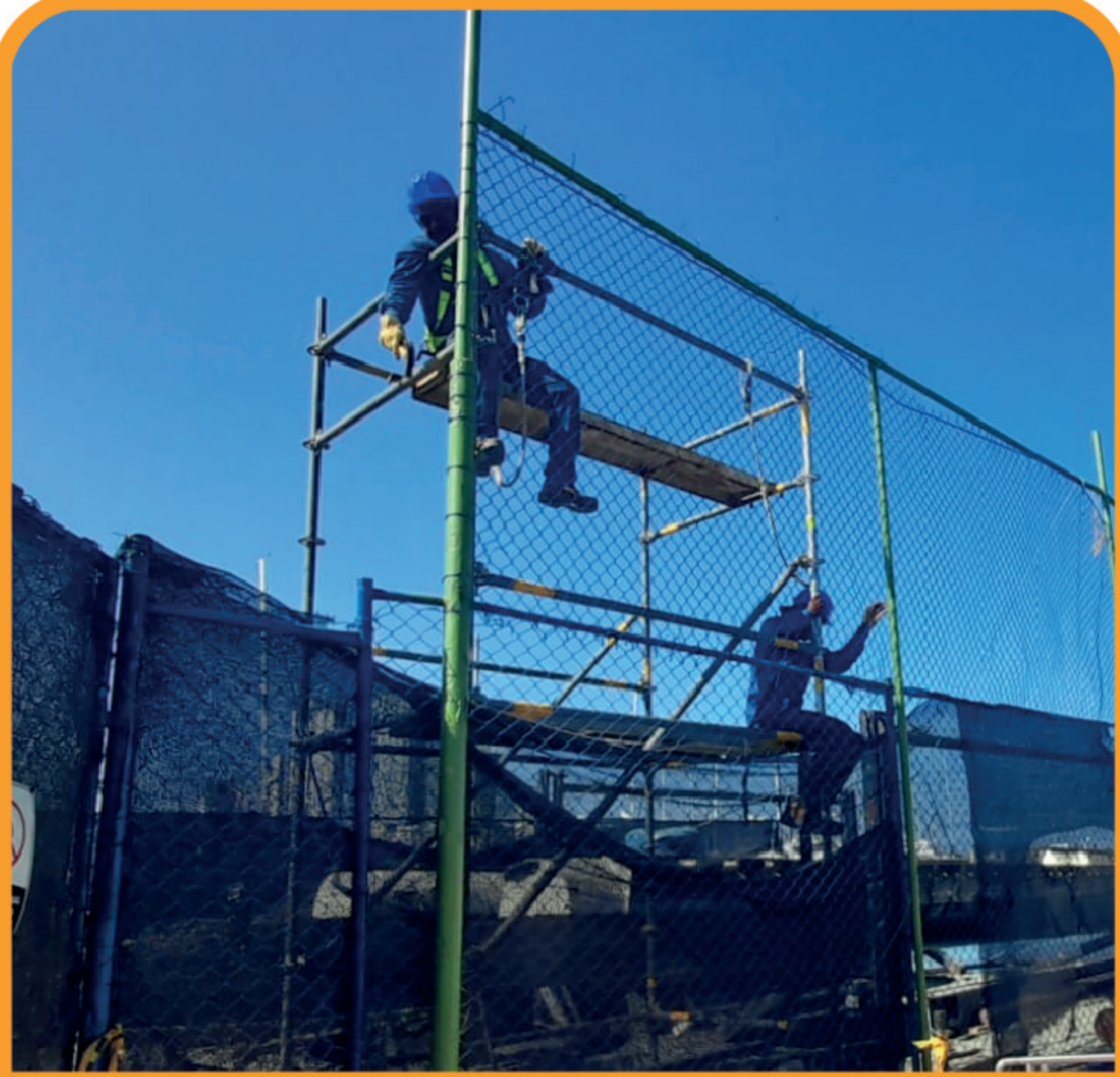
Mantenimiento de malla en sincro elevador
