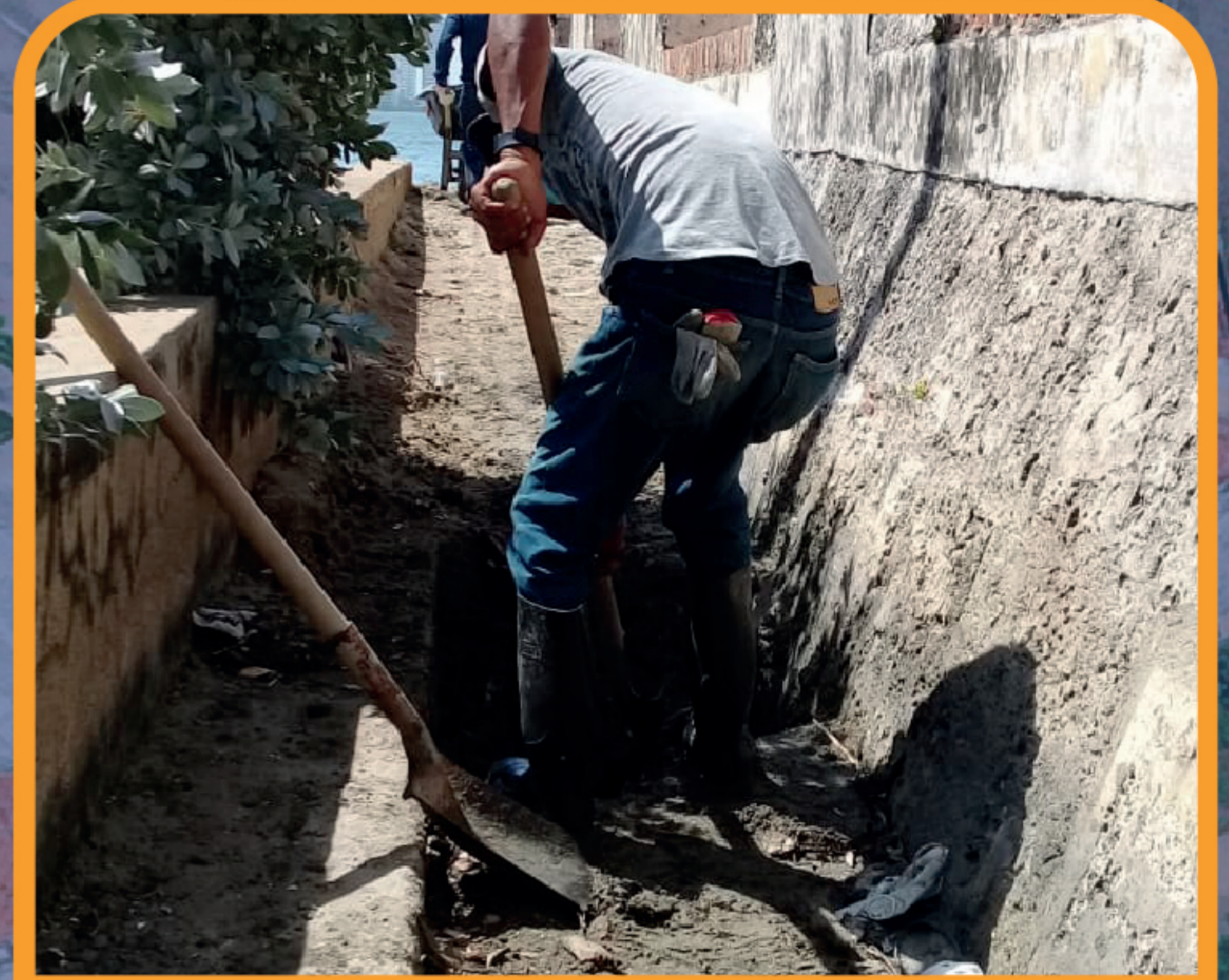
Limpieza canal del Fuerte
