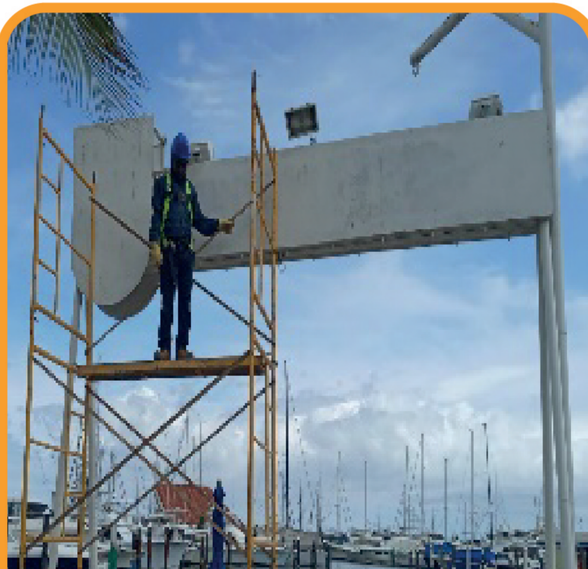
Desmante de estructura Zona de Pesaje
