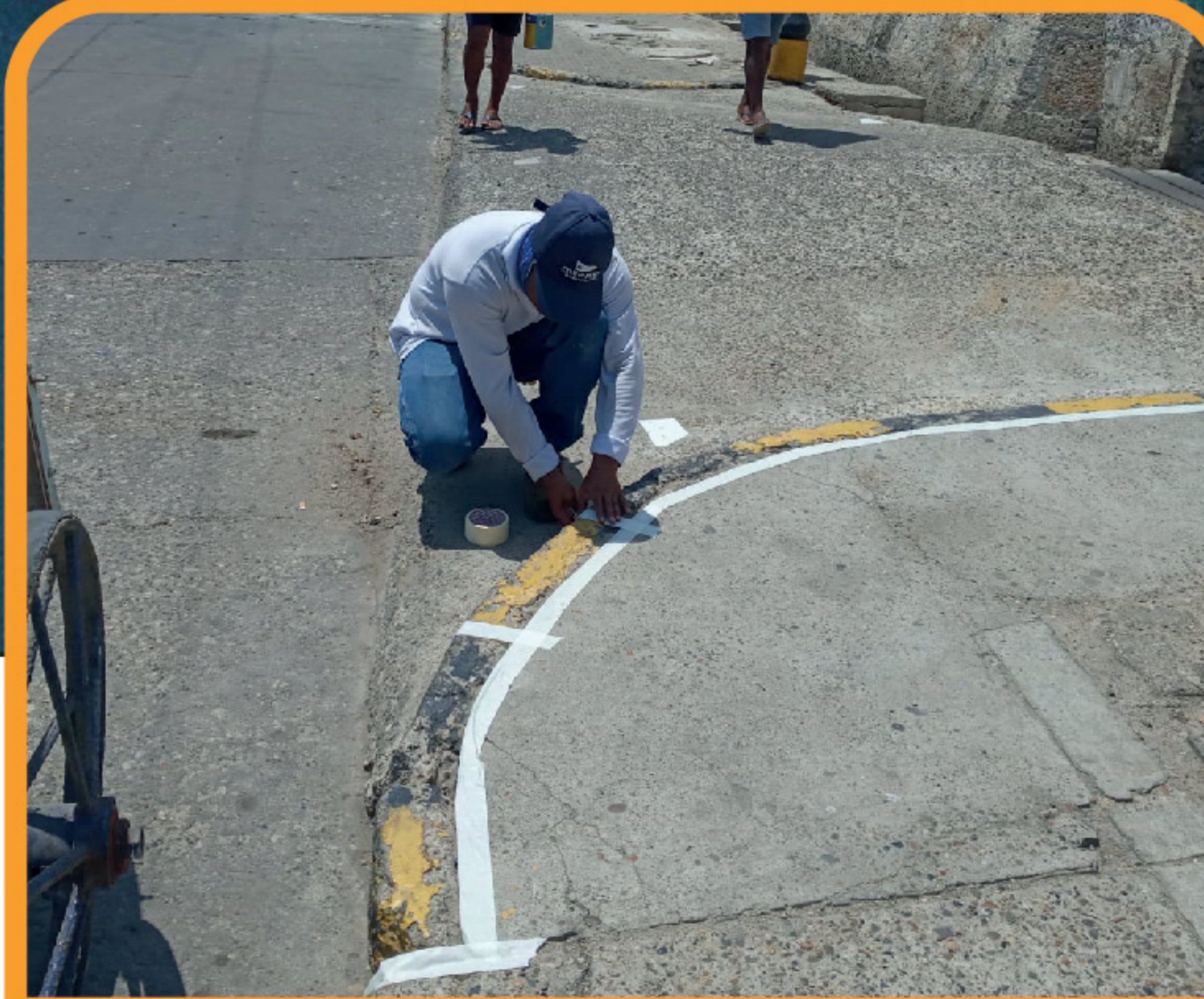
Mantenimiento pintura línea de seguridad
