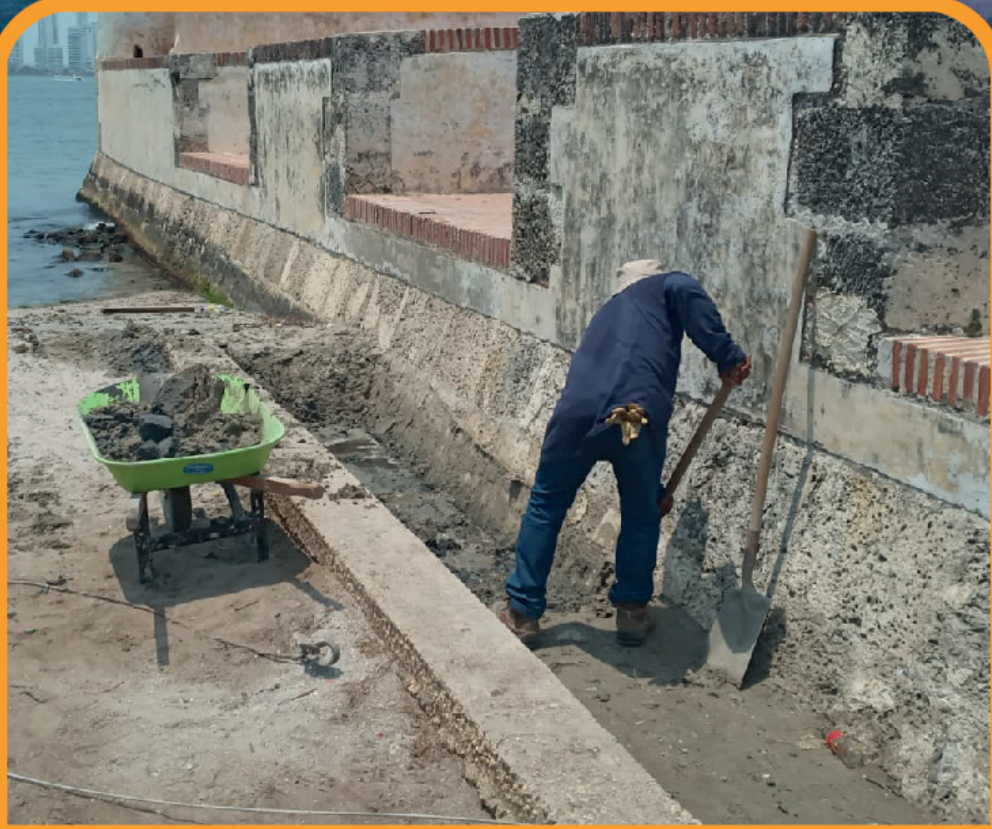
Limpieza canal del Fuerte
