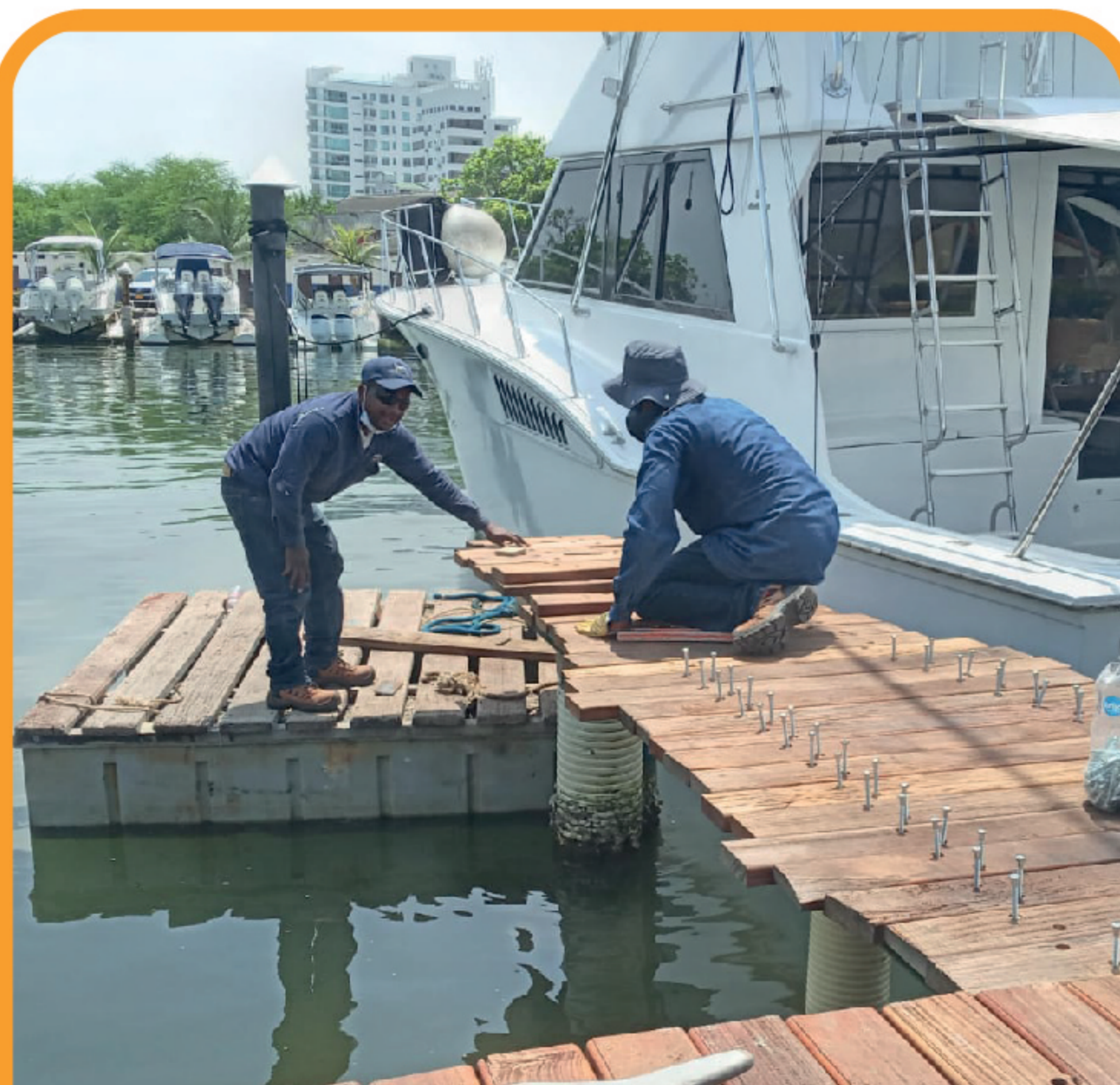
Construcción de finger Muelle 1
