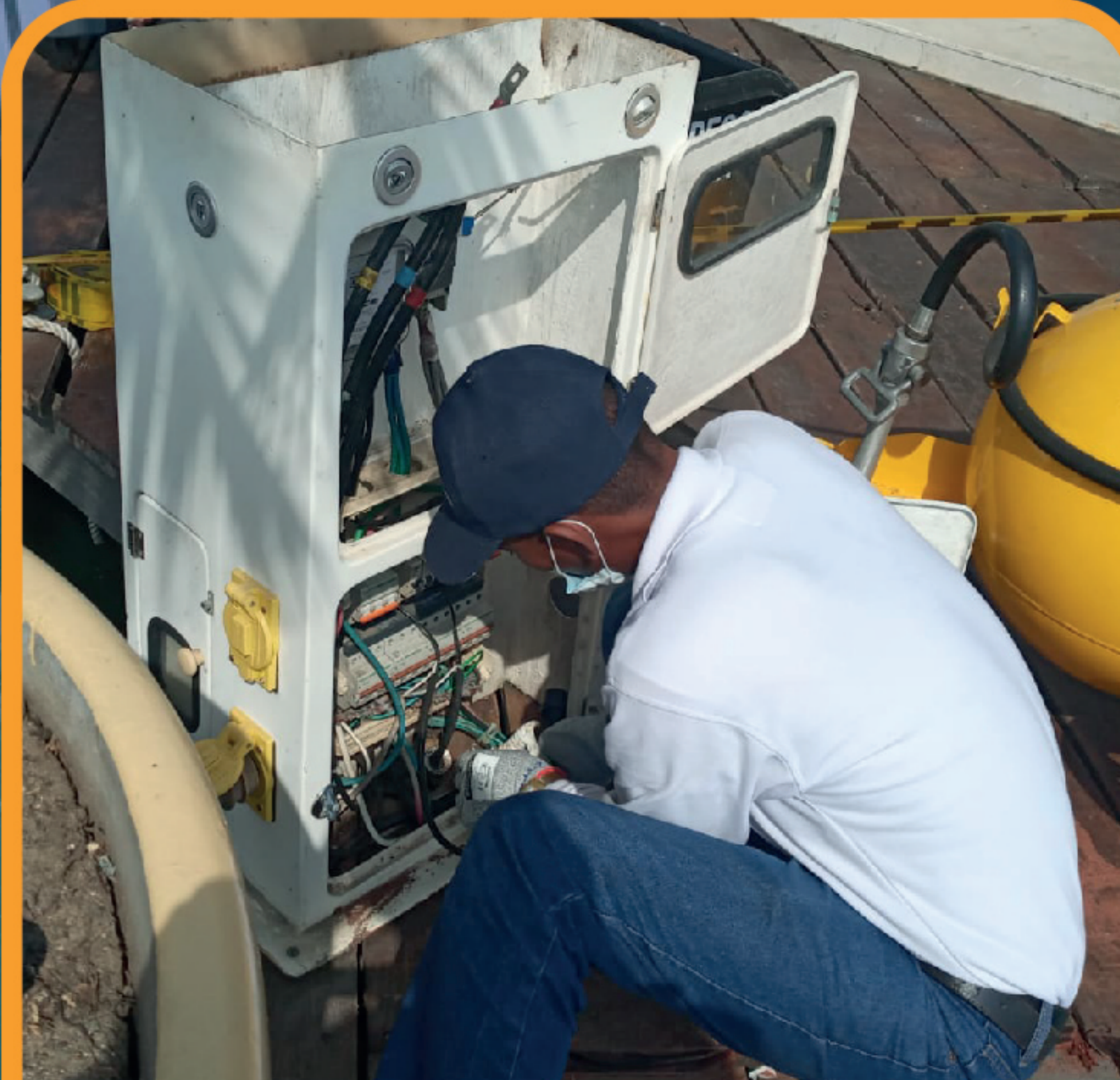
Mantenimiento cajas eléctricas
