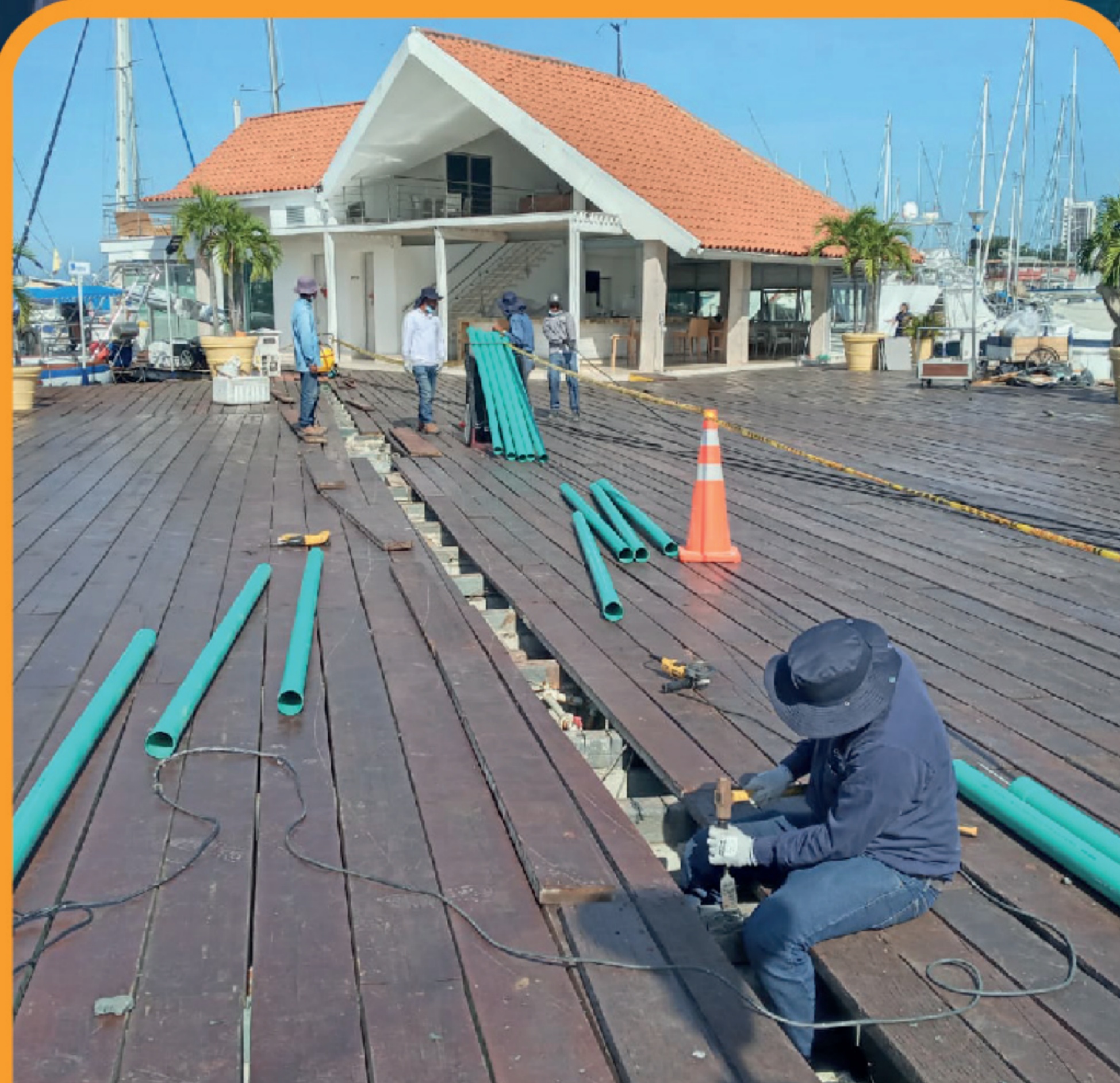
Cambio tuberías eléctricas
