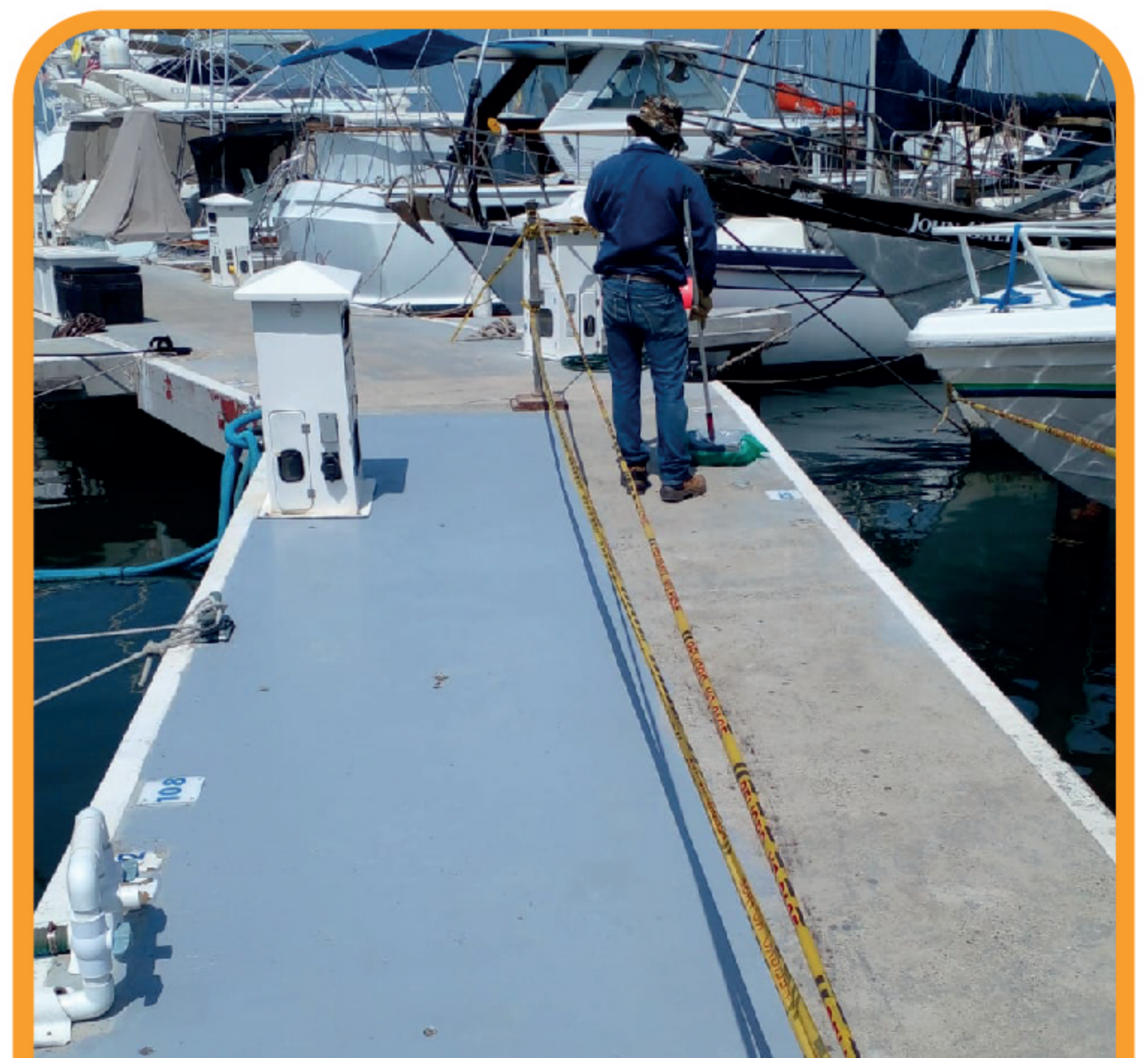
Aplicación de pintura gris epóxico en Muelle 2
