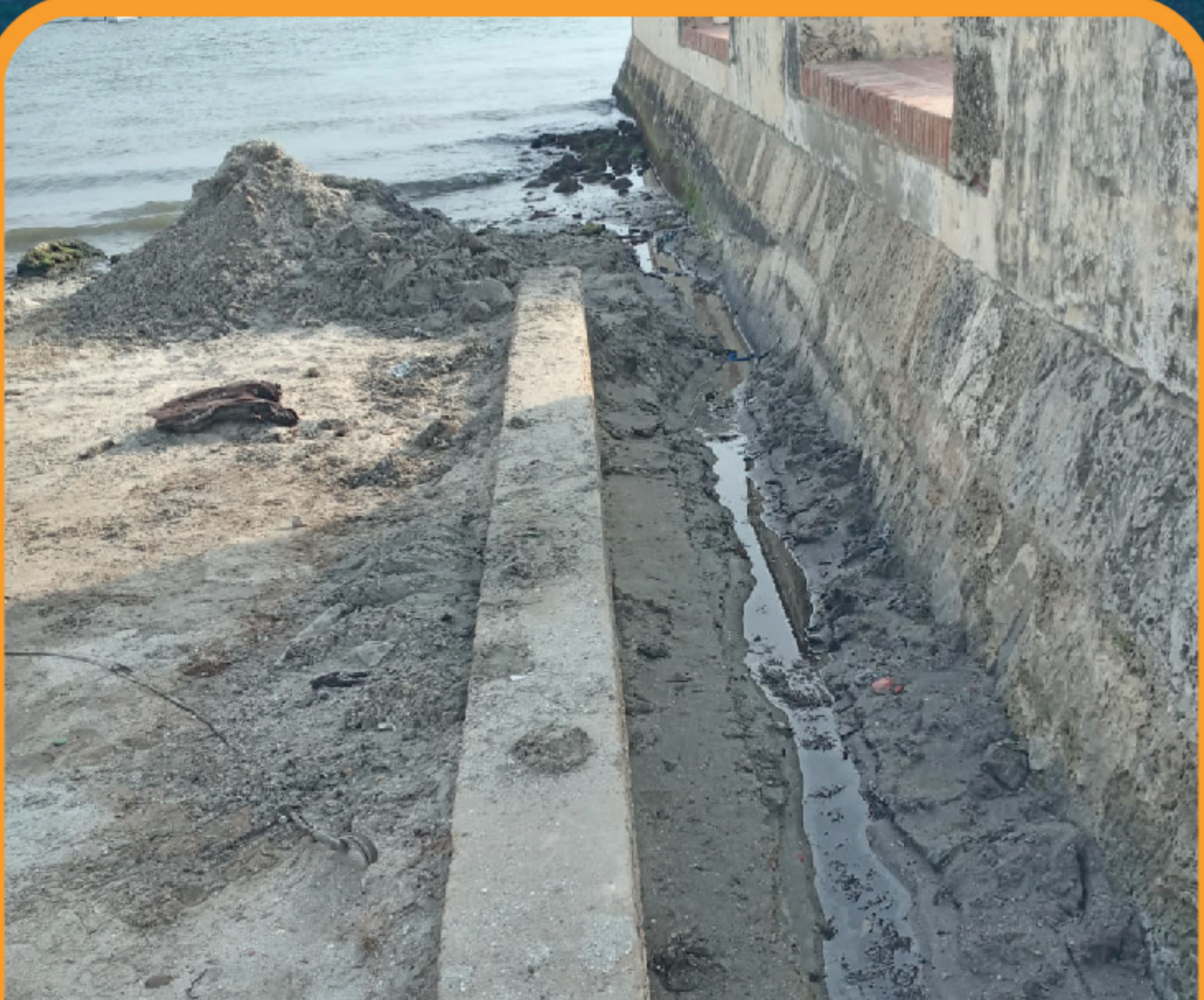
Limpieza canal del Fuerte
