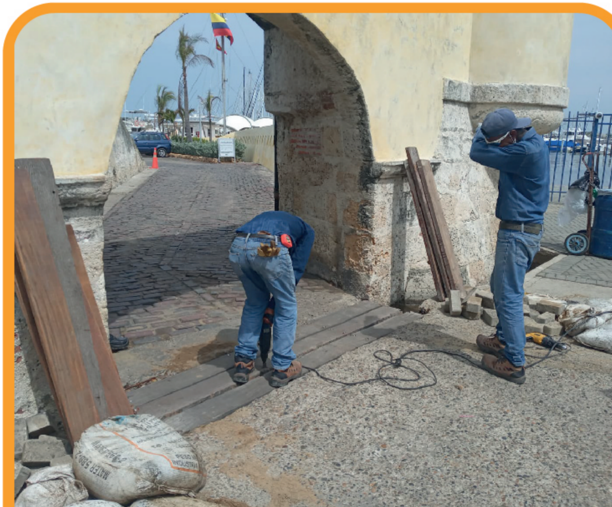
Mantenimiento puente de entrada al Fuerte
