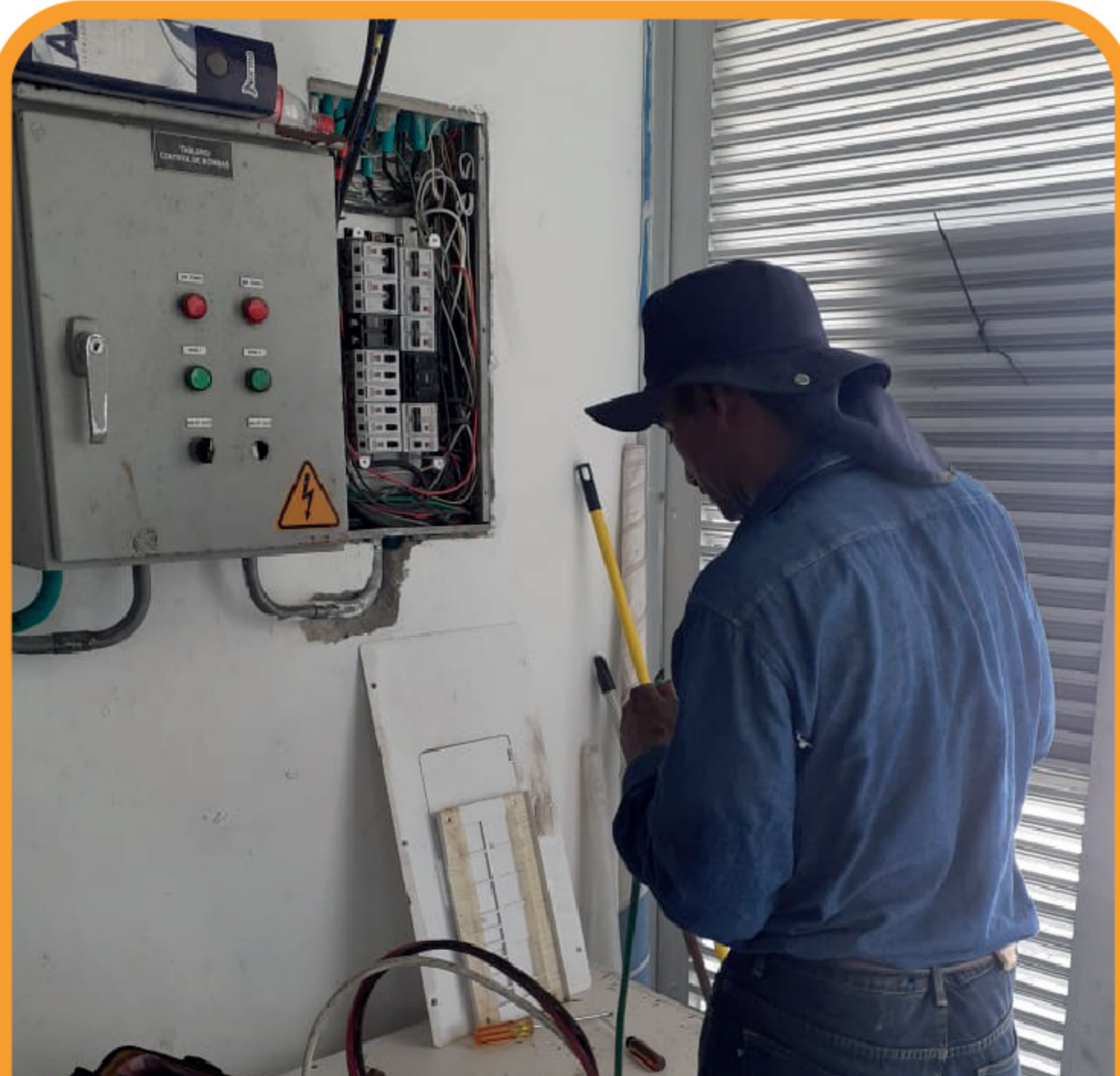
Mantenimiento de caja eléctrica Zona de Residuos
