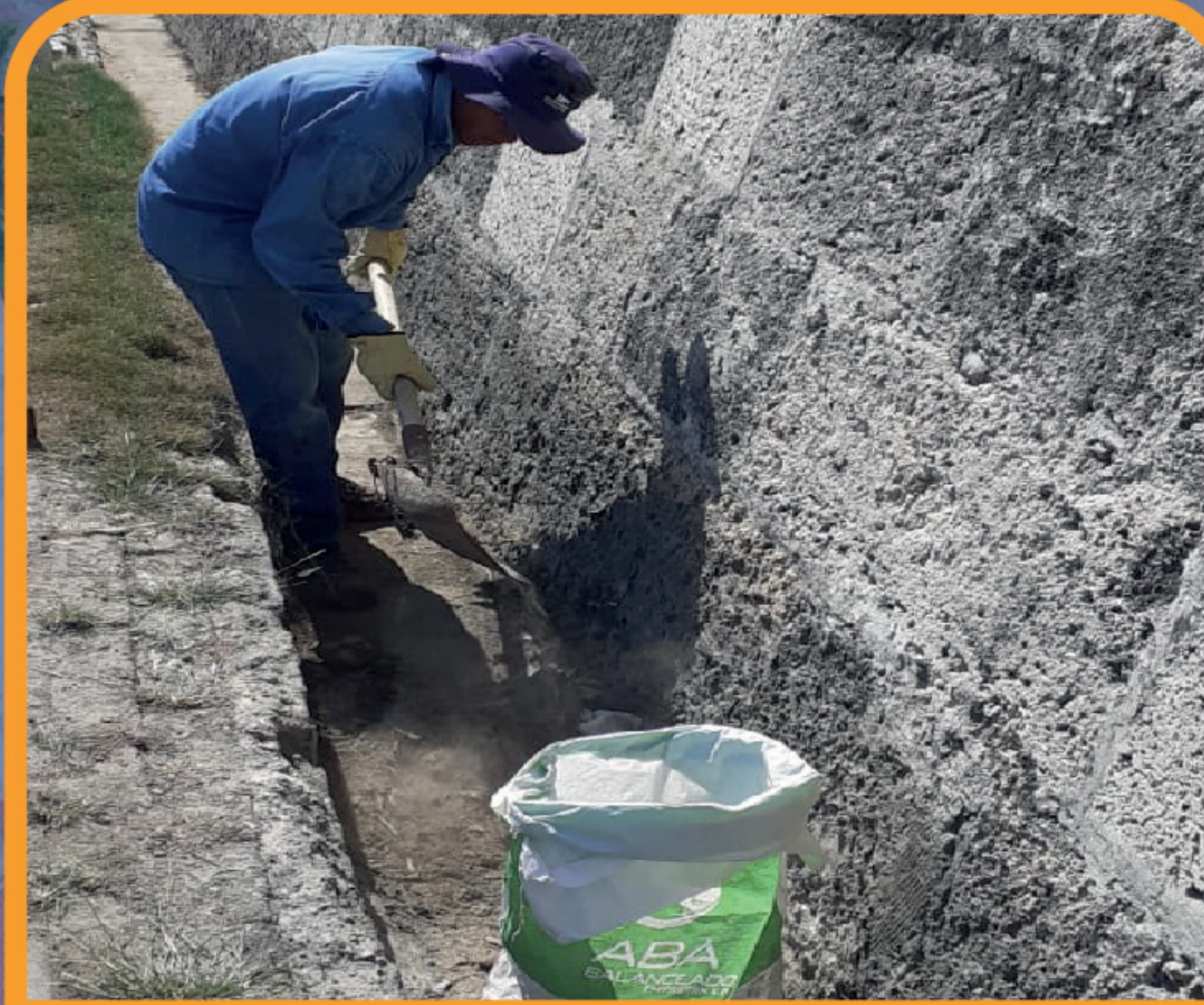
Limpieza canal del Fuerte
