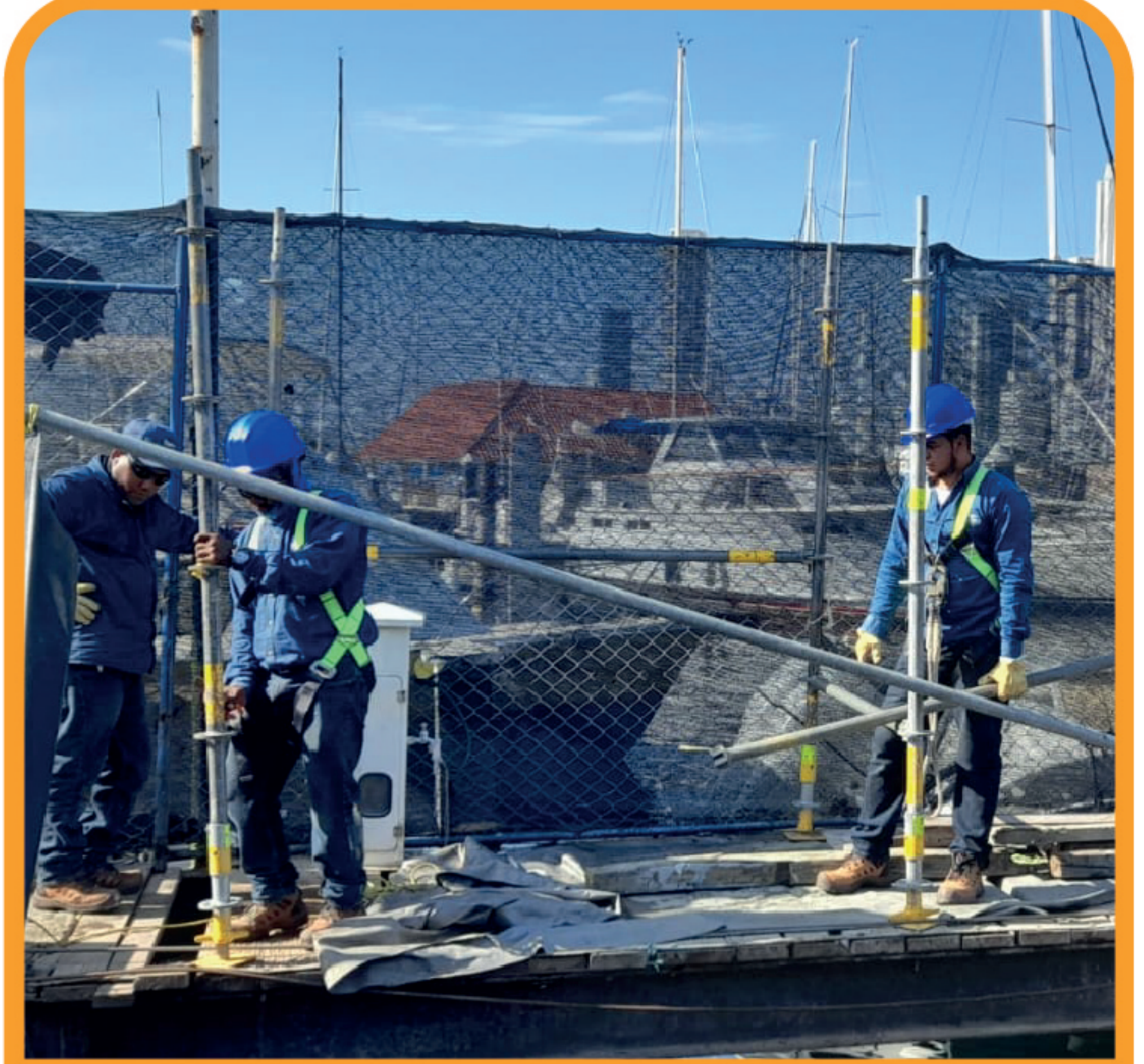
Mantenimiento de malla en sincro elevador
