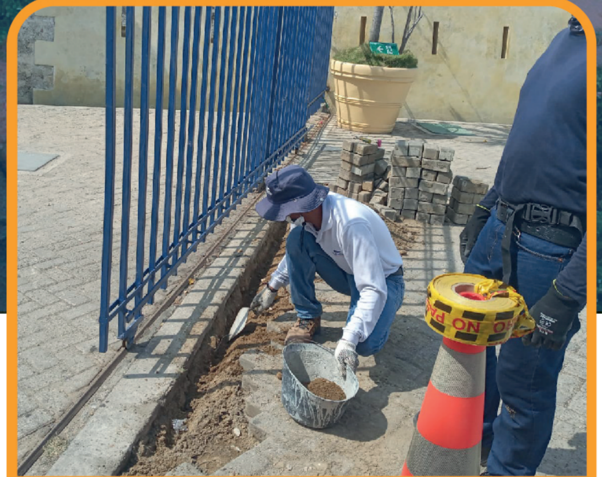
Instalación de línea eléctrica para puerta automática
