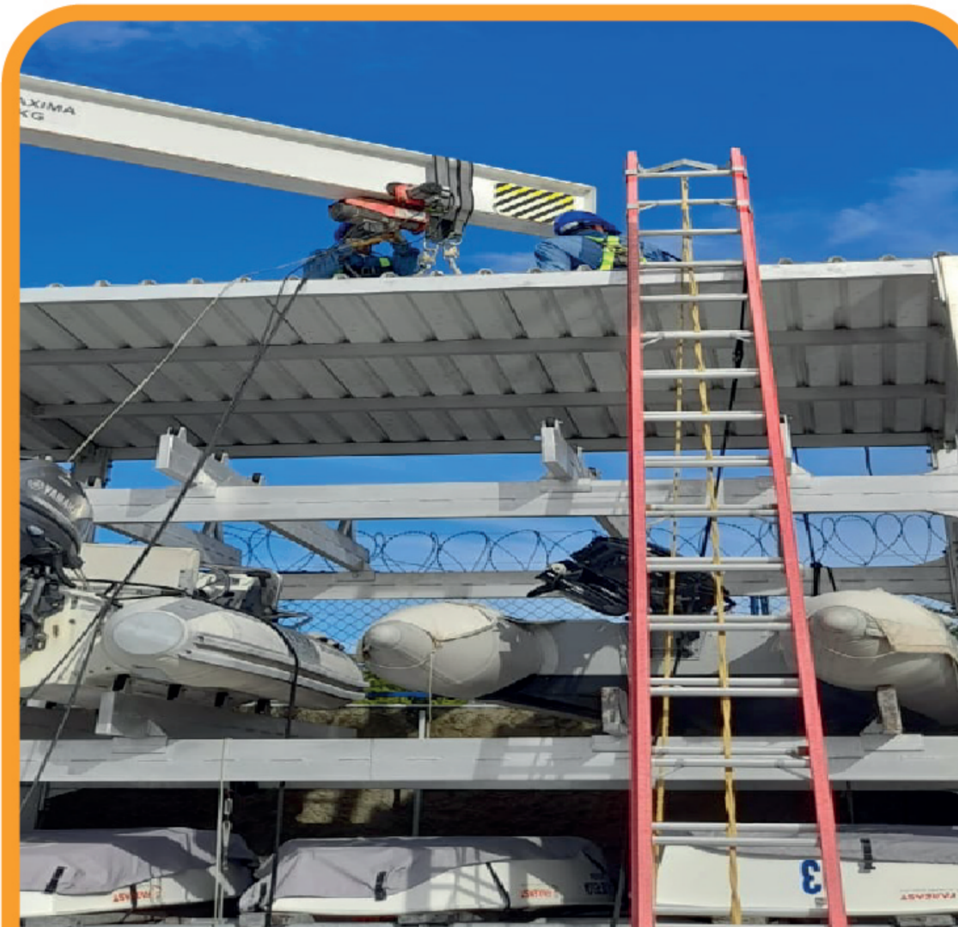
Mantenimiento polipasto en marina seca
