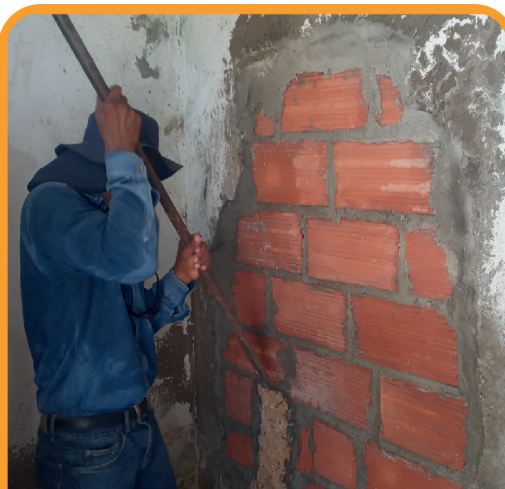
Reconstrucción de muro de lockers
