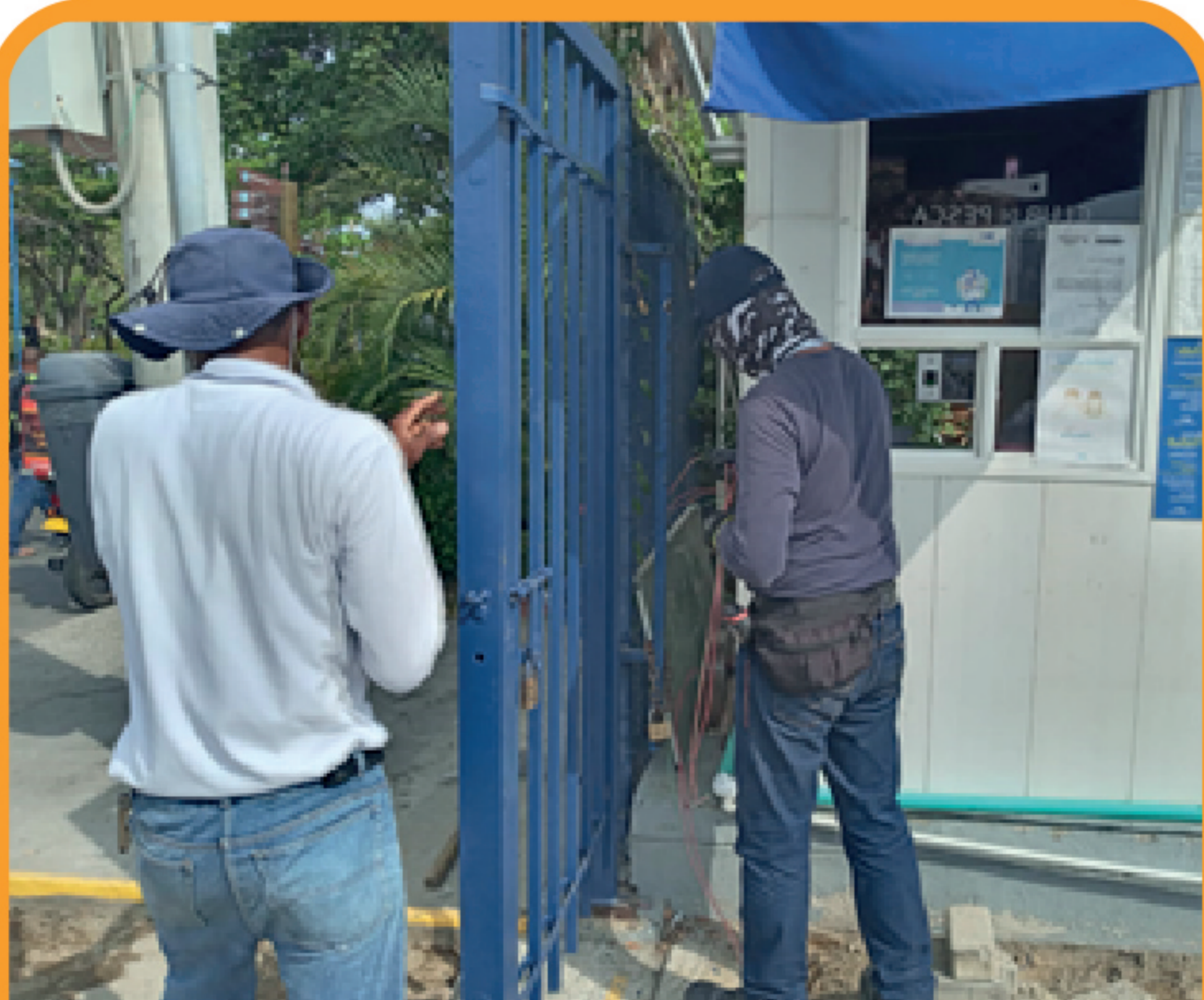
Instalación de línea eléctrica para puerta automática
