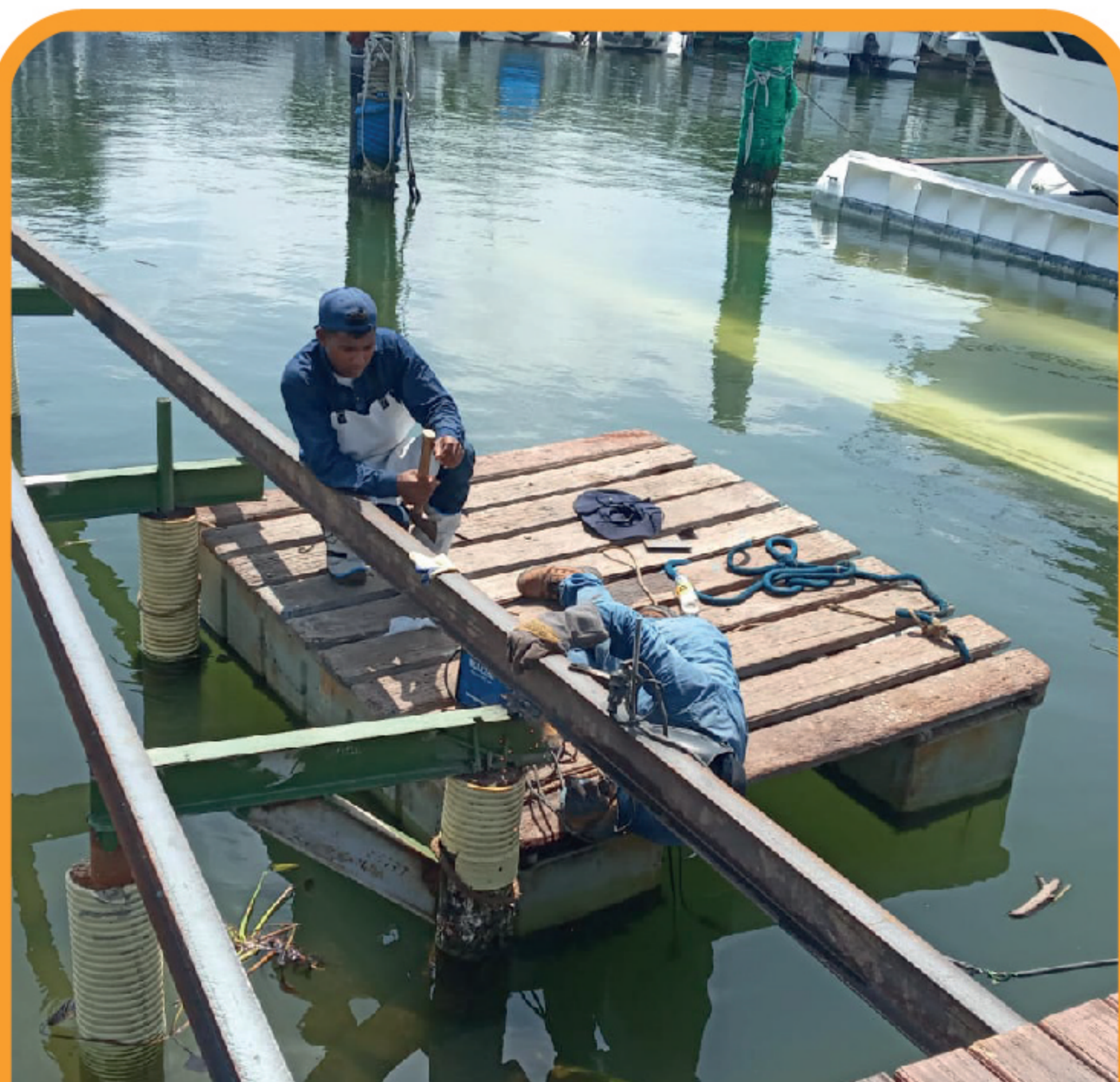
Construcción de finger Muelle 1
