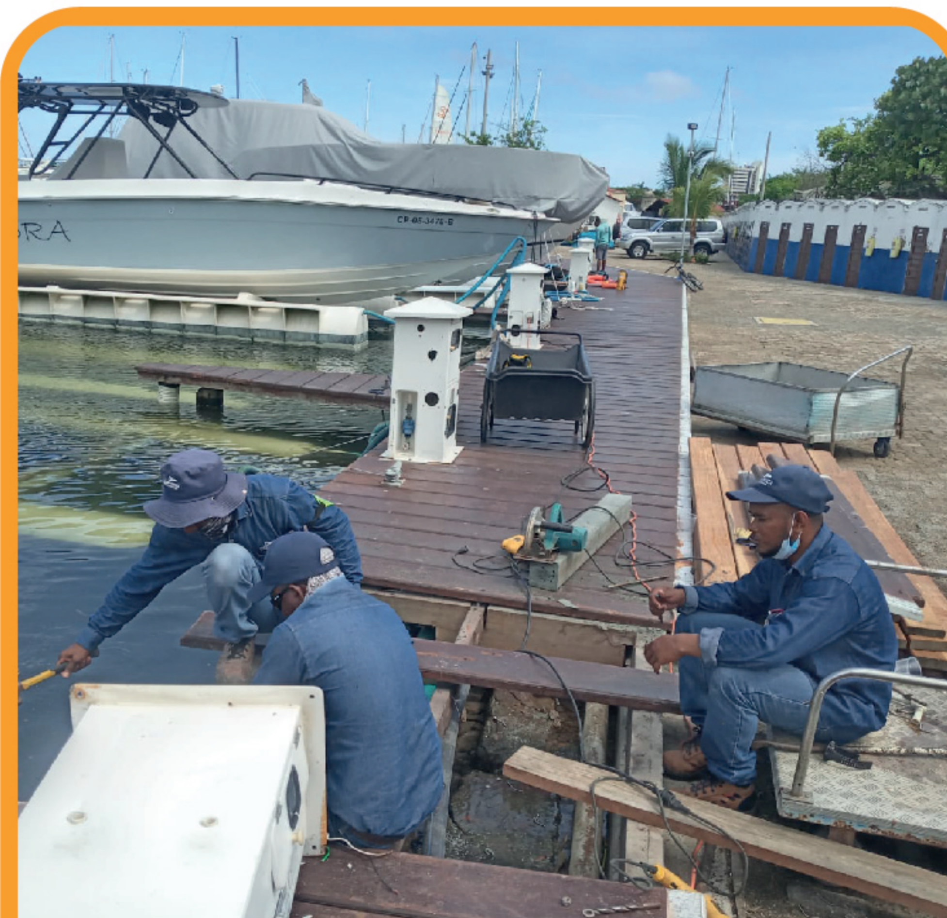
Mantenimiento de viga Muelle 2
